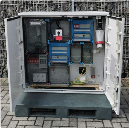
Die Einspeiseverteilung ist für den Anschluss der GSM-R Basisstation an das Energieversorgungsnetz vorgesehen.
