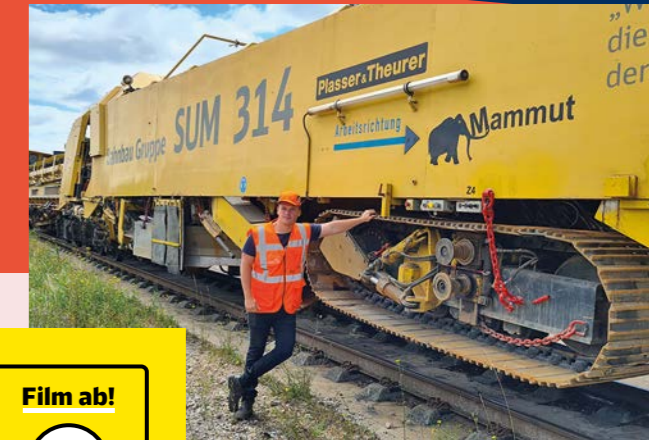
Lucas vor dem Gleisbauzug SUM 314 Mammut
