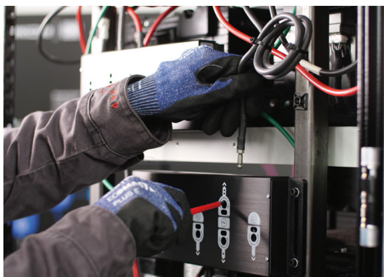
Nahaufnahme eines Wechselrichters
