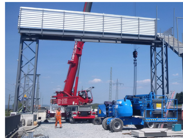
Abb.: Fußgänger Behelfbrücke
